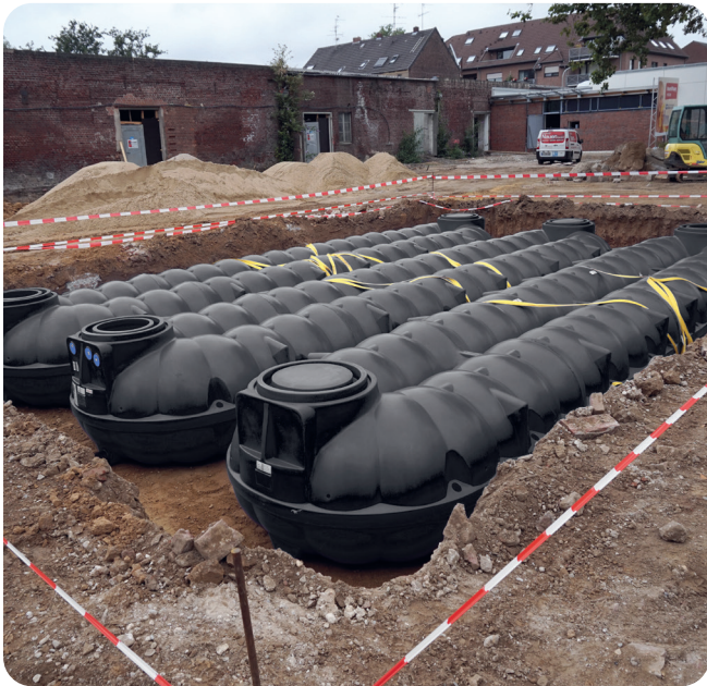
Exemple d'intégration: Grande installation réservoir plat NEO 3 x 20.000 litres
