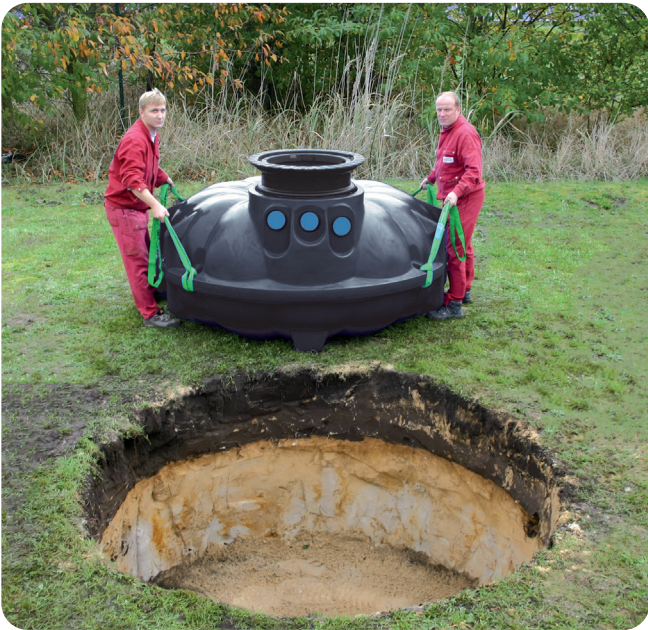
Exemple d'installation: Réservoir plat NEO 3.000 litres
