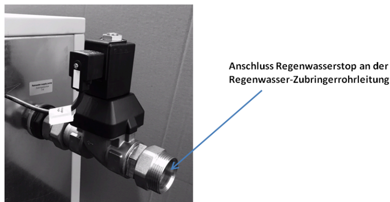
Figure 54 : raccordement hydraulique du stop-eau de pluie
