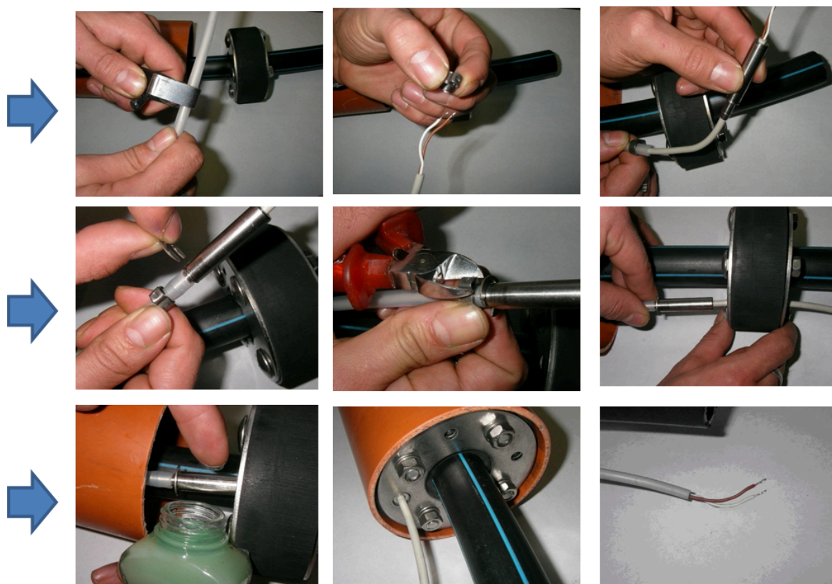
Figure 57 : Installation du câble de raccordement avec tuyau de protection dans le kit d'étanchéité de l'entrée de la maison
